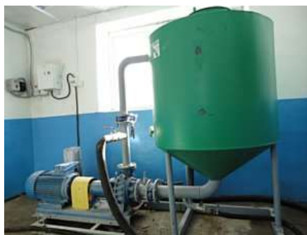
Рисунок 4.4 – Установка для проведения ферментативного гидролиза овса
