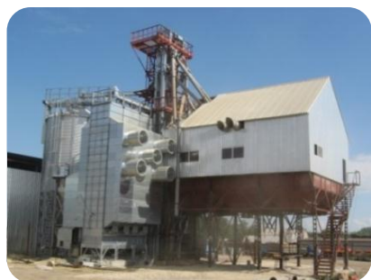
а) Блок вертикальных двухканальных авторегулируемых делителей потока зерна (СХПК «Сосновый Бор»)
