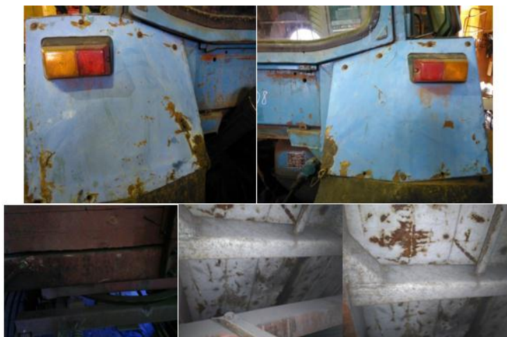
Рисунок 1. Коррозионные процессы на кузовных элементах тракторов
